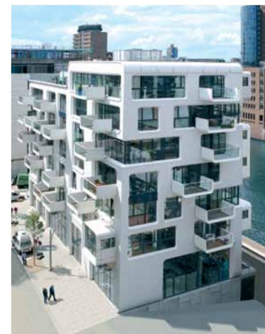
дополнено балконами; ширина окна соответствует ширине комнаты. Точные расчеты позволили уменьшить применение стальных конструкций и бетонных блоков в пользу панорамного остекления, а часть элементов, например, балконы, являются сборными блоками фабричного изготовления. Окна снабжены системой теплоизоляции. Входящие в состав строительной смеси гранулы слюды обеспечивают легкое сияние, исходящее от фасада при ярком солнечном свете. ■
